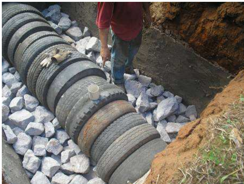
Figura 18: Fossa ecológica Fonte: Site Agência Minas (2012)
