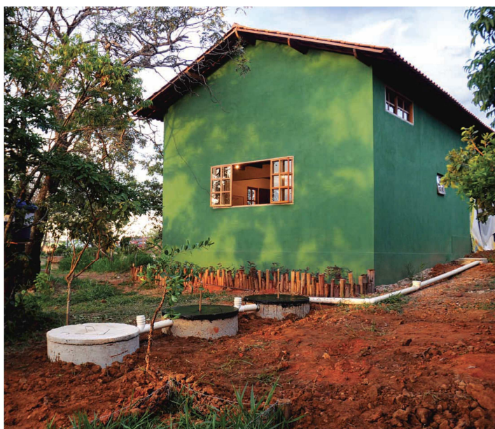
Figura 19: Fossa séptica biodigestora Fonte: EMBRAPA (2010)
